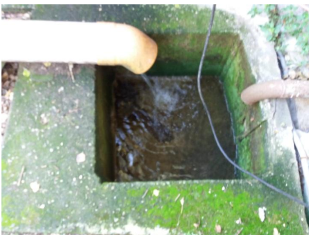
Pozzetto di scarico nel Torrente del caffè
