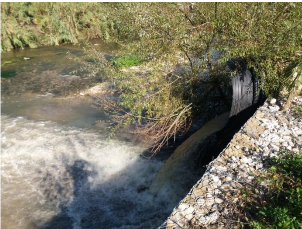
Figura 15. Scarico del depuratore e scarico di by-pass (ora liquami tal quali) nel fiume Tusciano.
