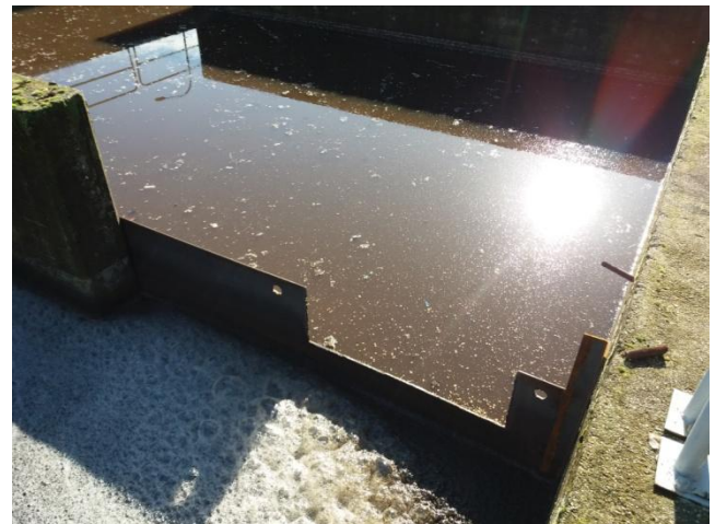
Vasca di disinfezione. Uscita per la filtrazione
