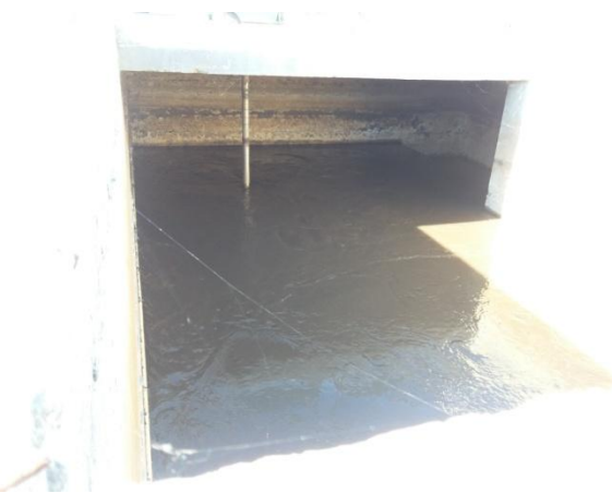
Figura 9. Vasca di omogeneizzazione.
