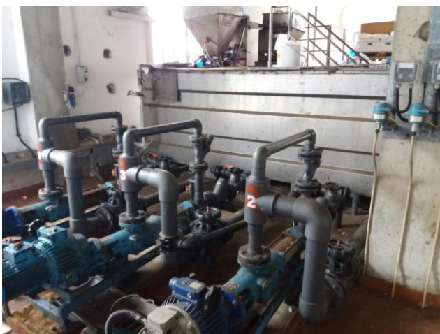
Preparatori del polielettrolita
