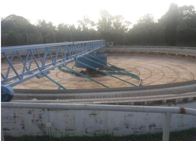
Dettaglio vasca sedimentazione primaria in manutenzione
