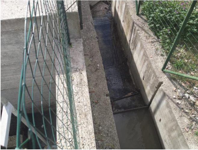
A destr canale di ingresso e sfioro. Sulla sinistra grigliatura manuale.
