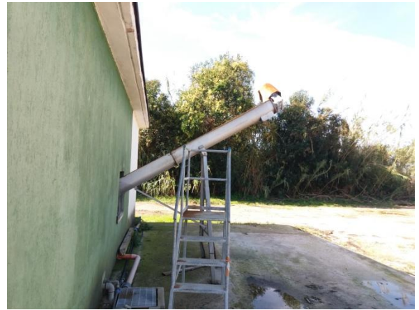
Figura 20. Scarico fanghi.
