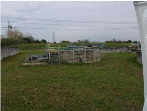
A sx scorcio della vasca di chiari flocculazione. A dx la vasca di sollevamento fanghi misti
