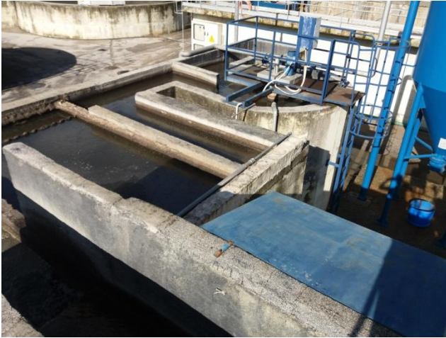
A sinistra la disolea tura e dissabbiatura. A destra la raccolta sabbie in silos
