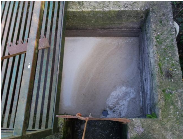
A destra pozzetto arrivo liquami. A sinistra il by-pass che va alla disinfezione.
