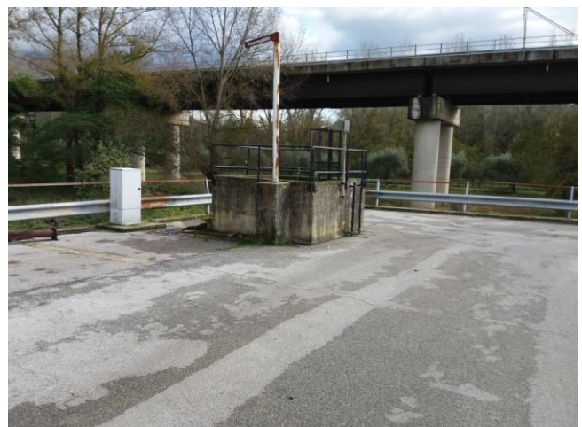
Pozzetto di scarico alla condotta snam
