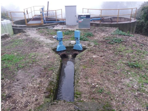
La saracinesca di sinistra è chiusa. A destra il passaggio alla vasca di ossidazione.
