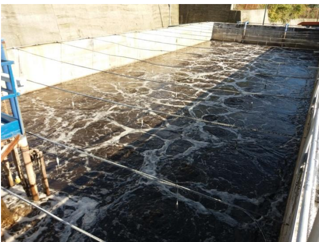
Vasca di equalizzazione, preareazione e bilanciamento
