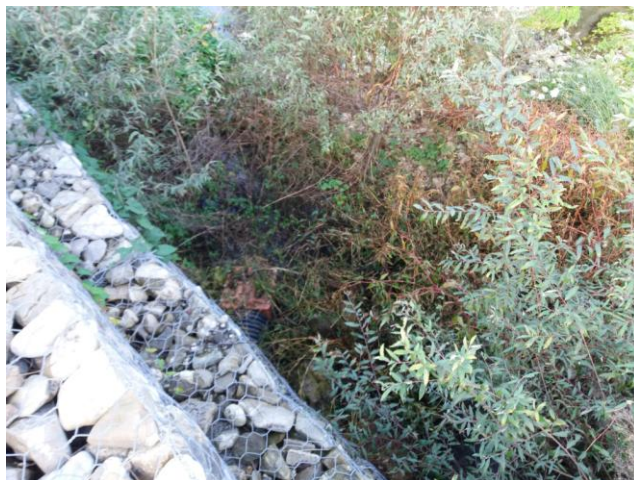
Scarico nel vallone
