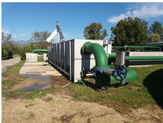
Figura 5. Dissabbiatura e disoleatura.
