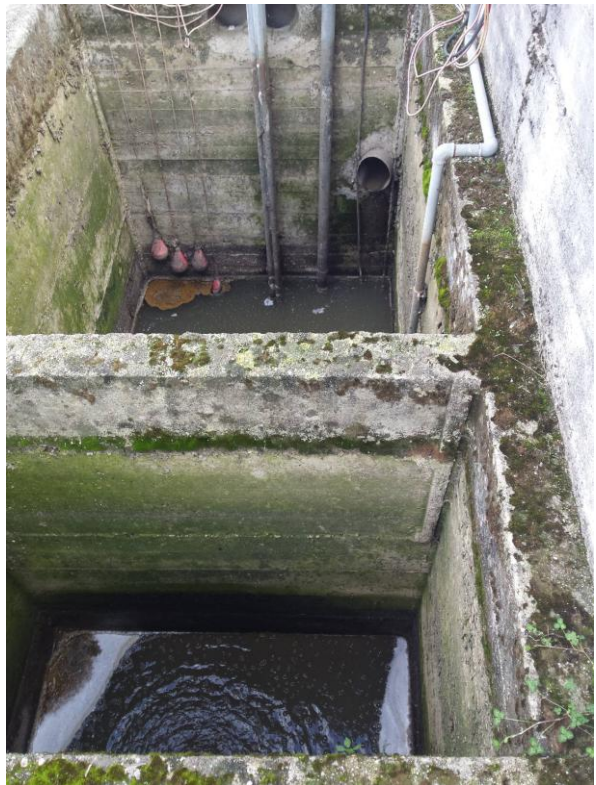
Disoleatura (non funzionante) e dissabbiatura
