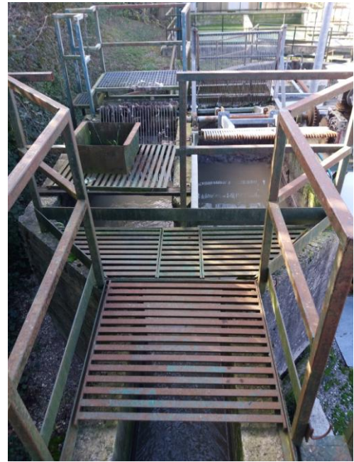
Grigliatura manuale e automatica
