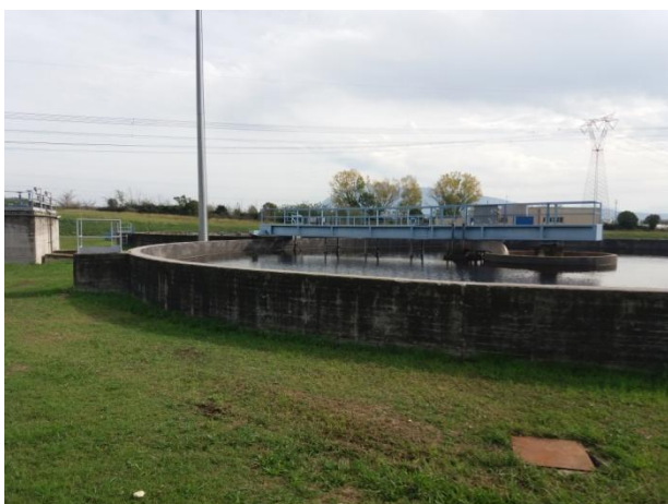
Vasca di sedimentazione secondaria
