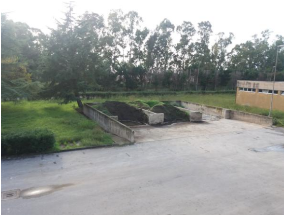
Letti di essiccamento delle sabbie provenienti dai selettori
