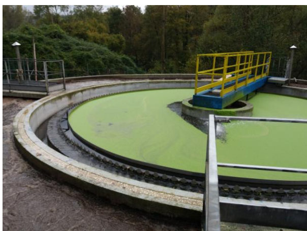
Vasca di sedimentazione
