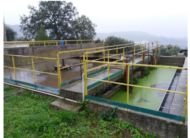
A sinistra la vasca di ossidazione, a destra la vasca di sedimentazione
