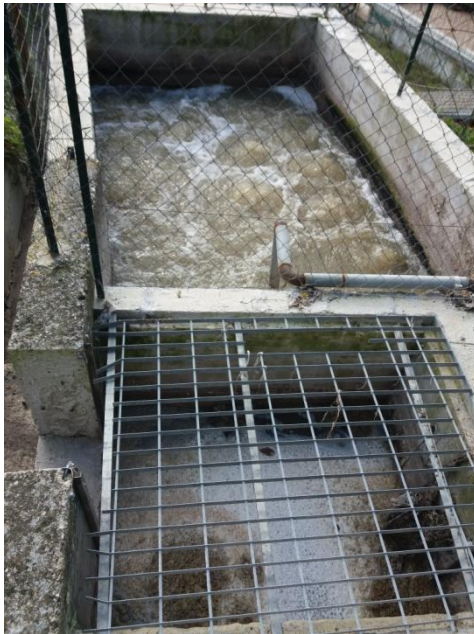
Davanti l'ingresso dei reflui. A sinistra lo sfioro e in fondo la dissabbiatura areata
