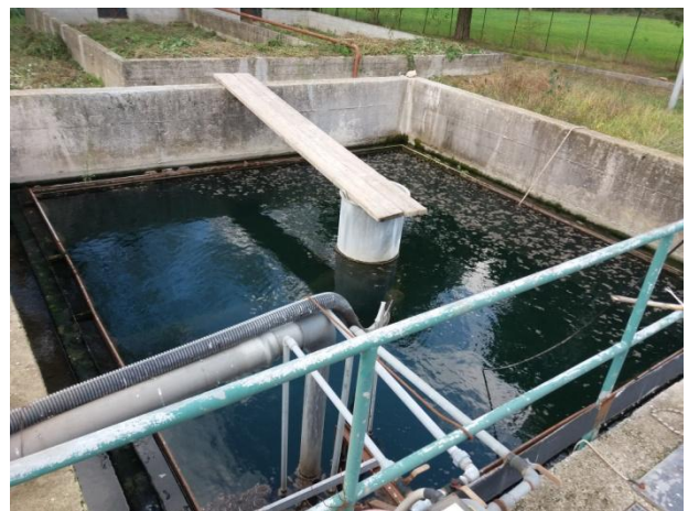
Vasca di sedimentazione. In fondo i letti di essiccamento
