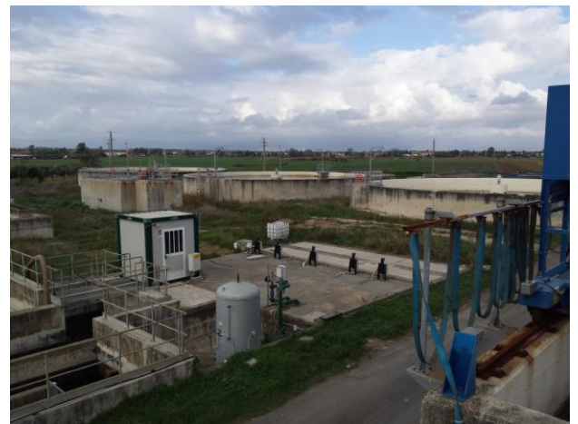
N. 3 vasche di sedimentazione primaria
