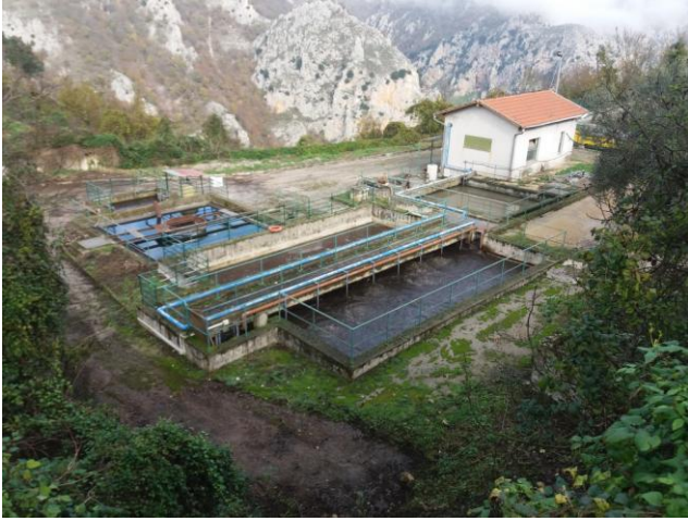
Impianto di depurazione
