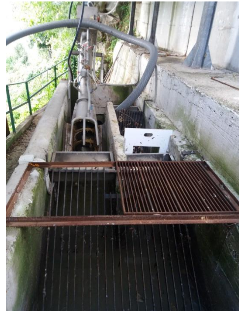
Grigliaura manuale e grigliatura automatica
