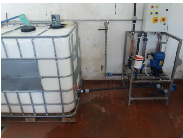
Preparatore polielettrolita
