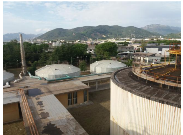
In primo piano sulla destra il digestore anaerobico. In secondo piano, le due cupole sono gli ispessitori
