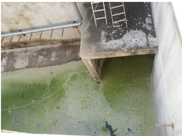
Dettaglio dell'ingresso del canale di dissabbiatura/preareazione in manutenzione
