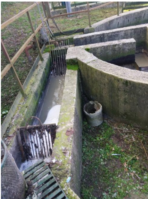
A destra pozzetto arrivo liquami. A sinistra il by-pass che va alla disinfezione.
