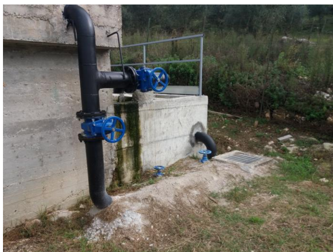
Pozzetto di scarico
