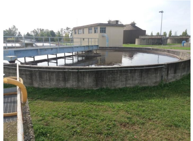
Vasca di sedimentazione primaria
