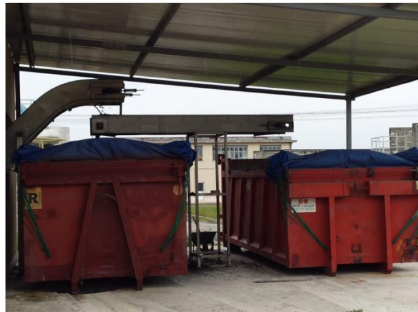
Raccolta fanghi dalla nastropressa
