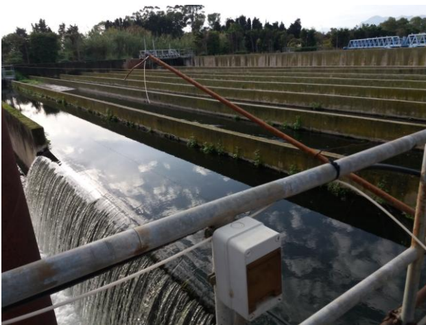
Vasca di disinfezione, aggiunta di antischiumogeni
