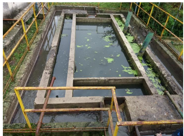
Vasca Imhof utilizzata solo per transito dei reflui nei canali esterni.
