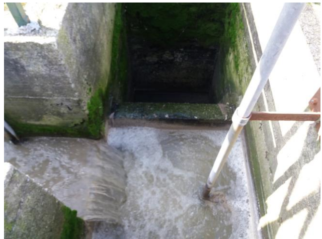
A sinistra il canale di collegamento tra la dissabbiatura ed il pozzetto (Figura in alto) che invia i reflui alle vasche di ossidazione.
