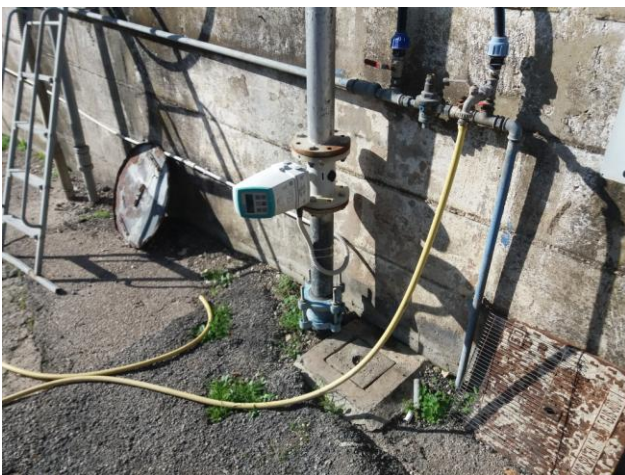
Misuratore di portata sulla mandata del sollevamento
