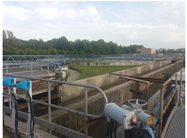
Panoramica lato sinistro sedimentazione primaria
