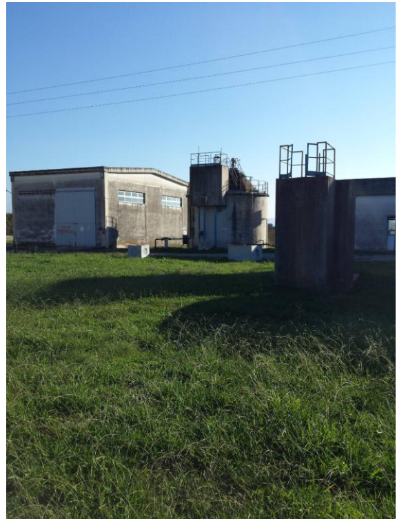
Digestore anaerobico 2° stadio
