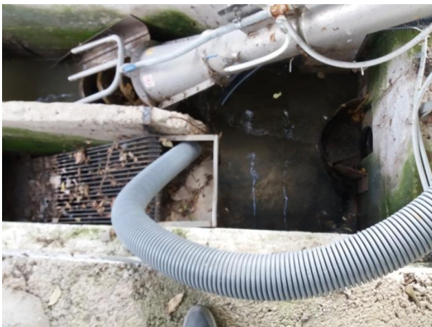
Davanti l'ingresso dei reflui. A sinistra lo sfioro e in fondo la dissabbiatura areata
