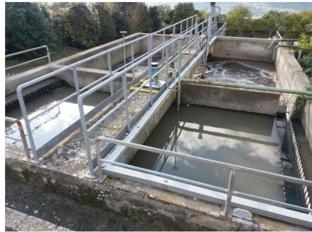
Davanti la vasca di sedimentazione primaria. In fondo la vasca di ossidazione
