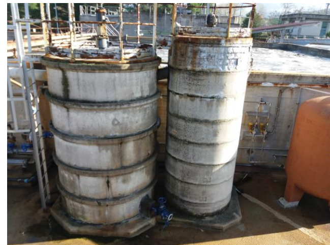
Silos chiariflocculazione
