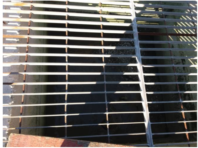
Passaggio in un pozzetto dove si accumulano sabbie
