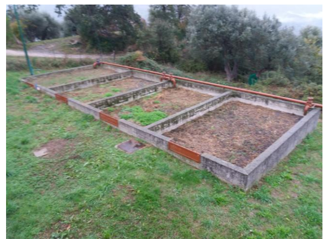
A sinistra la vasca di ossidazione, a destra la vasca di sedimentazione
