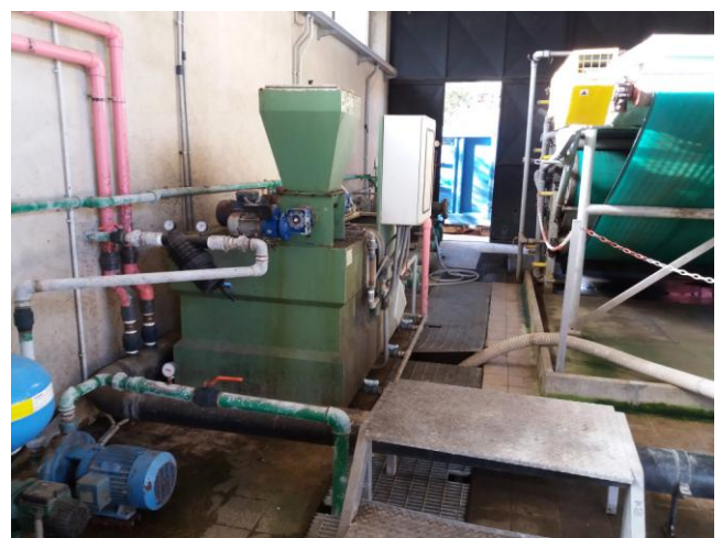
Preparatore polielettrolita
