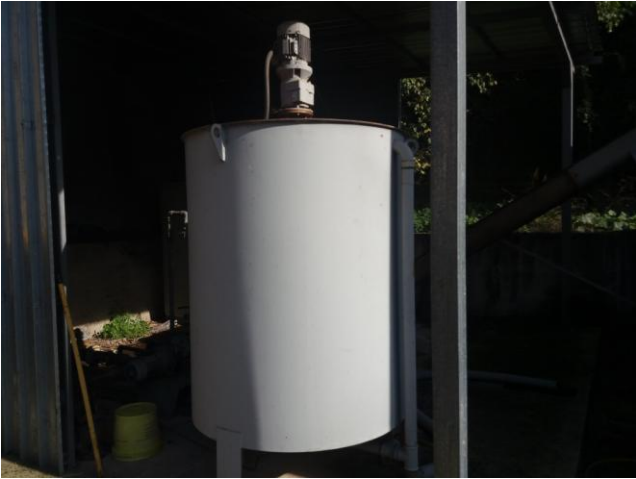
Preparatore polielettrolita
