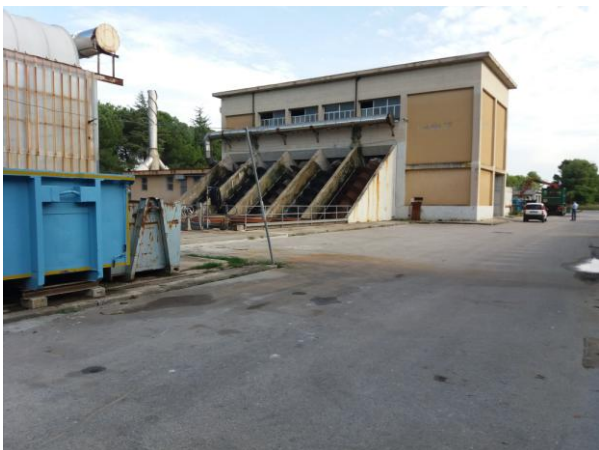
Panoramica raccolta grigliato e sollevamento
