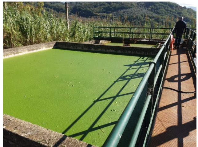
Davanti la vasca di ossidazione, in fondo la vasca di sedimentazione. Linea non funzionante
