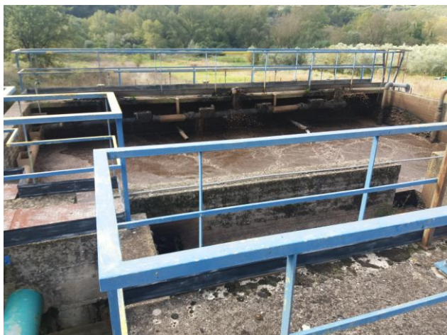
In lontananza la vasca di prede nitrificazione. Davanti la vasca di ossidazione
