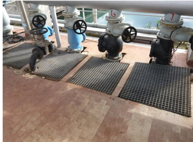
Vasca di raccolta e sollevamento reflui e rifiuti liquidi
