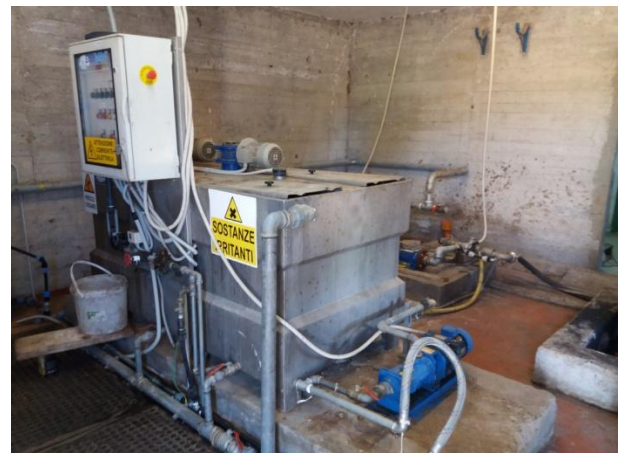
Figura 18. Preparatore di polielettrolita.
