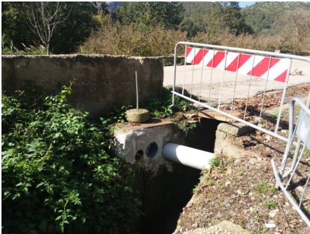
Sfioro del penultimo pozzetto della rete fognaria prima dell'immisione dei reflui al pozzetto della figura successiva.
