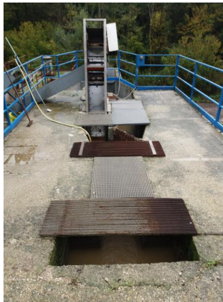
Davanti il pozzetto di arrivo dei reflui, dietro la grigliatura manuale ed automatica.
