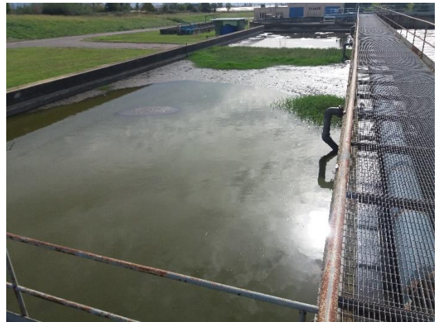
Vasca di ossidazione. In fondo il ricircolo fanghi
