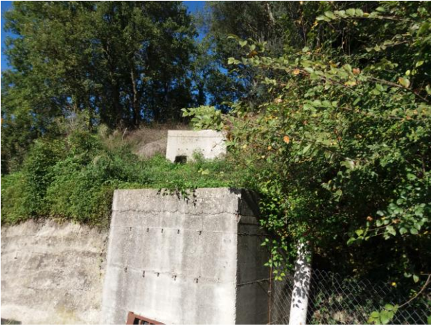
In alto ultimo pozzetto della rete fognaria
