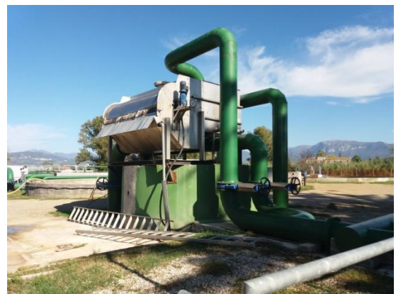
Figura 4. Rotostacciatura
