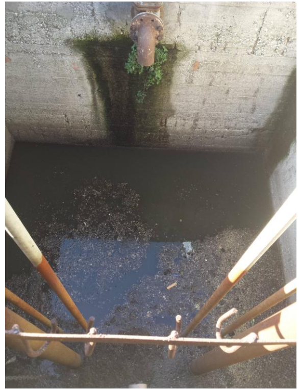
Vasca dissabbiatura/soffamento
