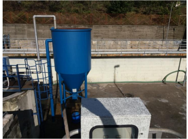
A sinistra la disolea tura e dissabbiatura. A destra la raccolta sabbie in silos
