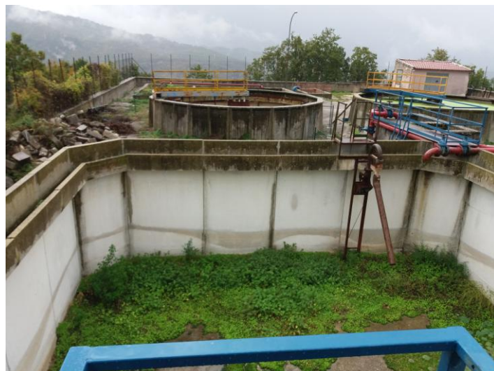
Parte di impianto non utilizzata.
