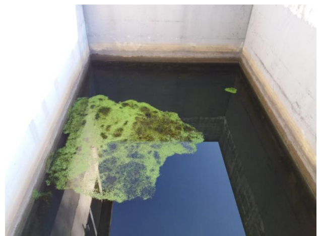
Vasca di accumulo
