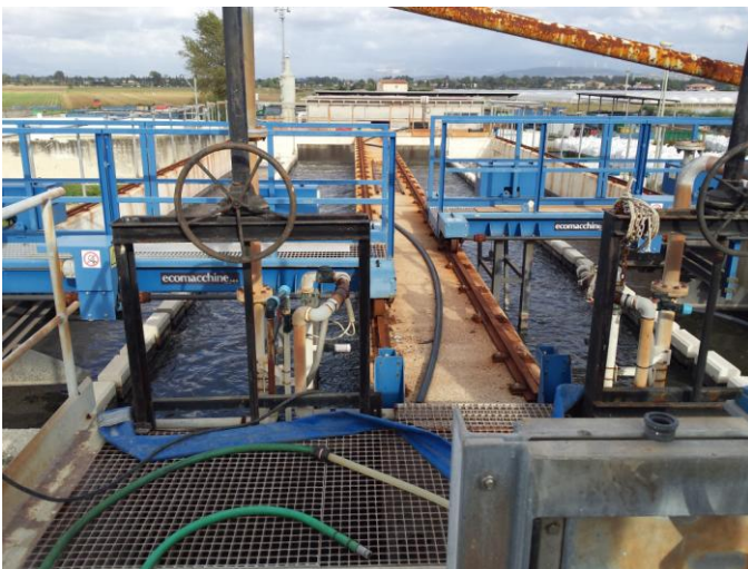
Dissabbiatura e disoleatura
