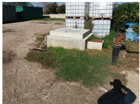
Figura 6. Pozzetto di raccolta olii e grassi.
