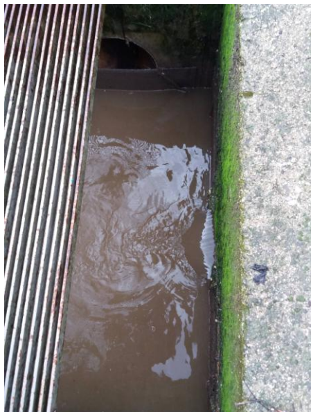
Vasca di raccolta dei reflui in ingresso. Sulla destra l'ingresso dei reflui, in alto lo sfioro.
