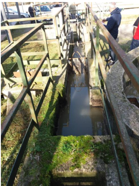
A sinistra il canale di collegamento tra la dissabbiatura ed il pozzetto (Figura in alto) che invia i reflui alle vasche di ossidazione.
