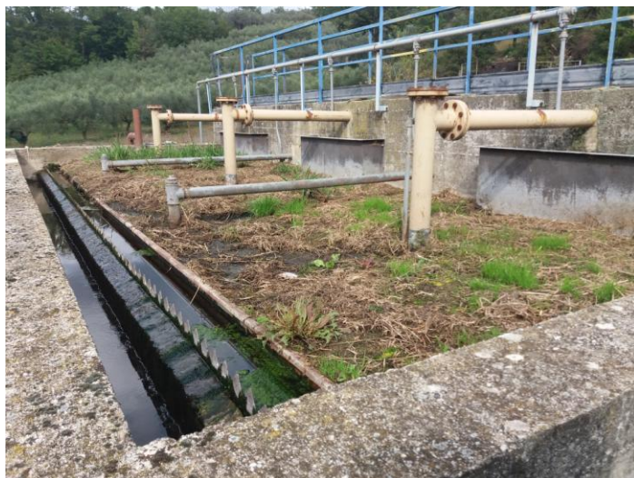
In lontananza la vasca di prede nitrificazione. Davanti la vasca di ossidazione
