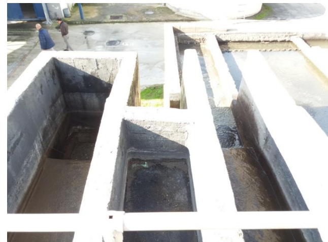
A destra passaggio dalla grigliatura ai trattamenti primari. A sinistra l'uscita delle acque bianche
