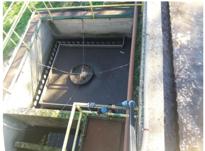
Sedimentatore funzionante
