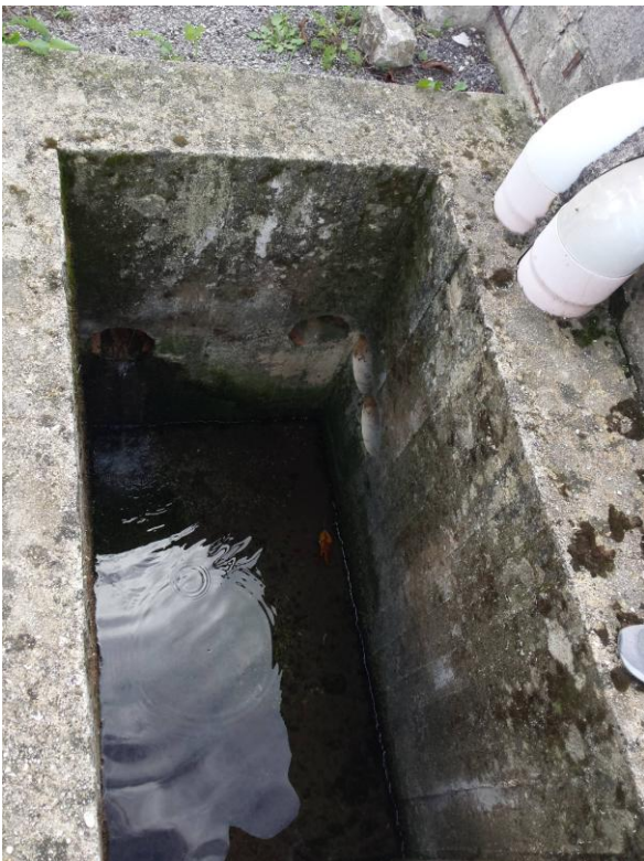
Scarico e sfioro
