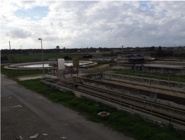
In primo piano le vasche di clorazione. In lontananza N. 2 vasche di sedimentazione secondaria
