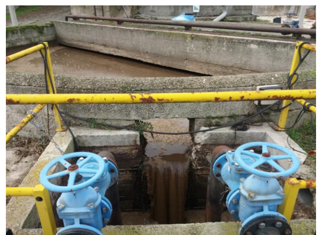
Pozzetto ricircolo fanghi
