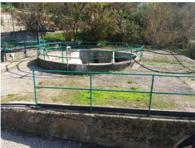
Ispessitore (vasca imhof)
