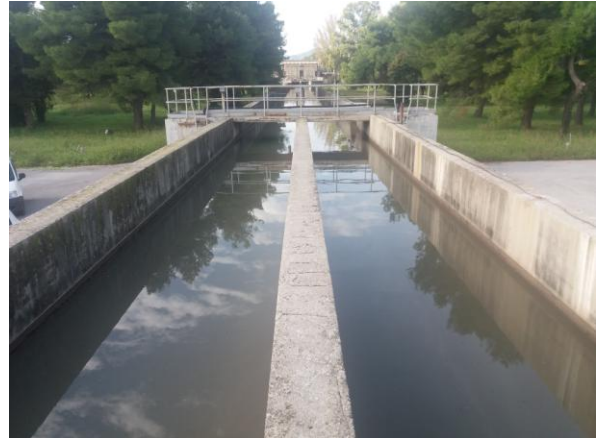
Preareazione, dissabbiatura e disoleazione vista da s-e
