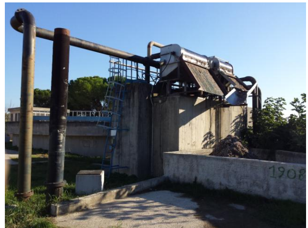
Rotostacciatura e dissabbiatura
