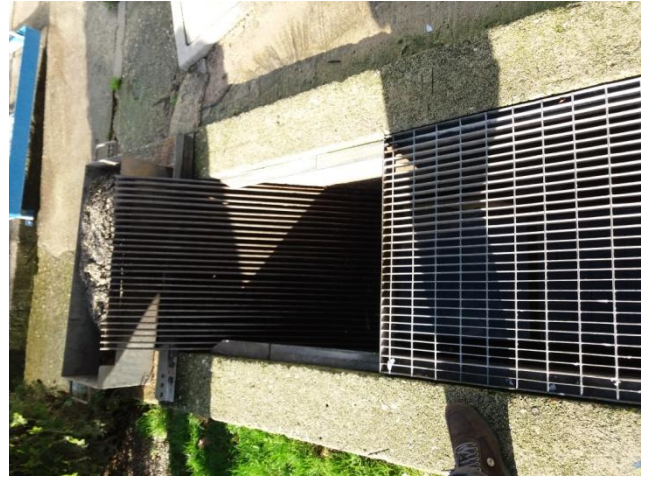
Grigliatura grossolana reflui in ingresso
