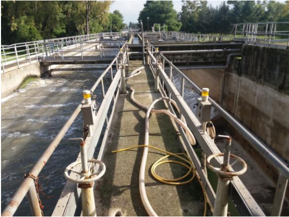
Preareazione, dissabbiatura e disoleazione vista da n-w
