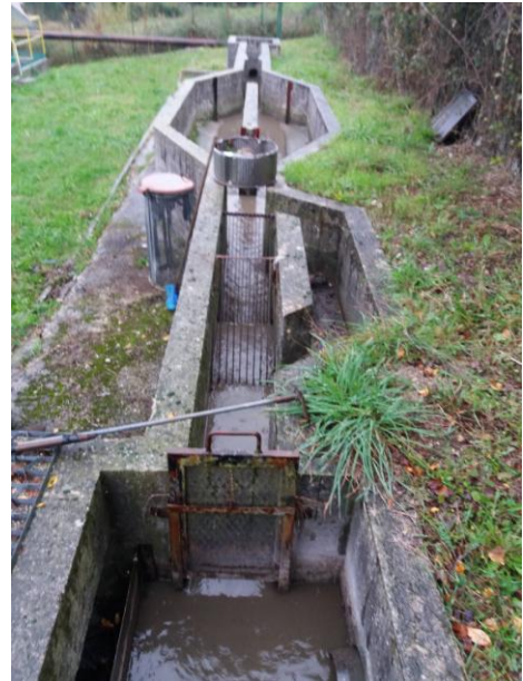
Grigliatura e dissabbiatura
