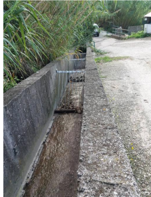
Il canale di sfioro del pozzetto nella figura precedente. Sono presenti n. 3 griglie
