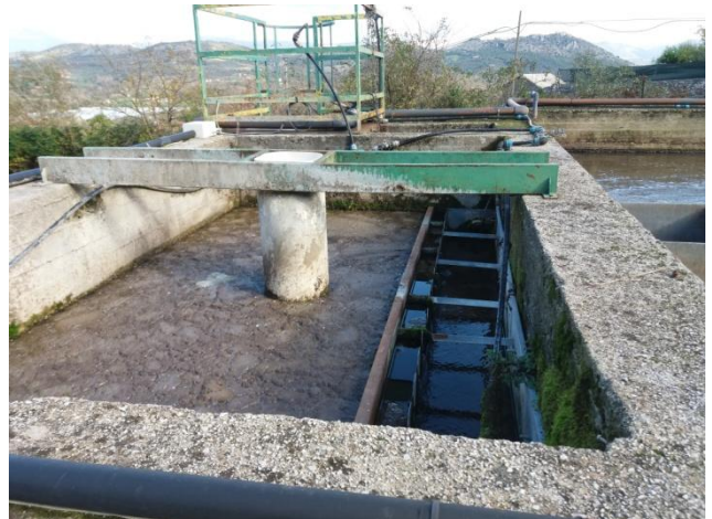
Vasca di sedimentazione
