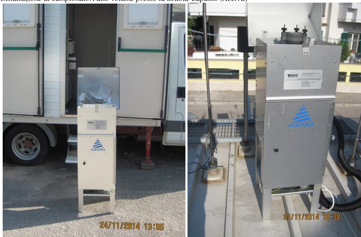
Fig.12: Installazione di campionatori alto volume presso la Scuola Capasso (Acerra)
